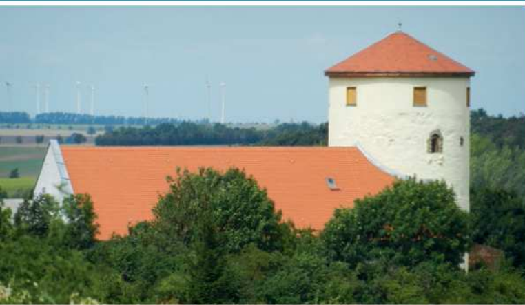
Prägt weithin sichtbar das Ortsbild von Freckleben und wurde umfassend saniert: Der Bergfried.
