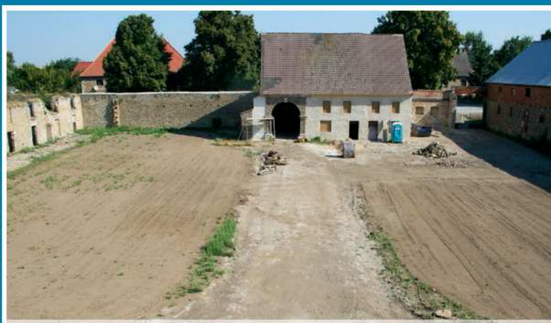
Nach Zeiten kollektiver Landwirtschaft wird das historische Torhaus fachgerecht saniert.
