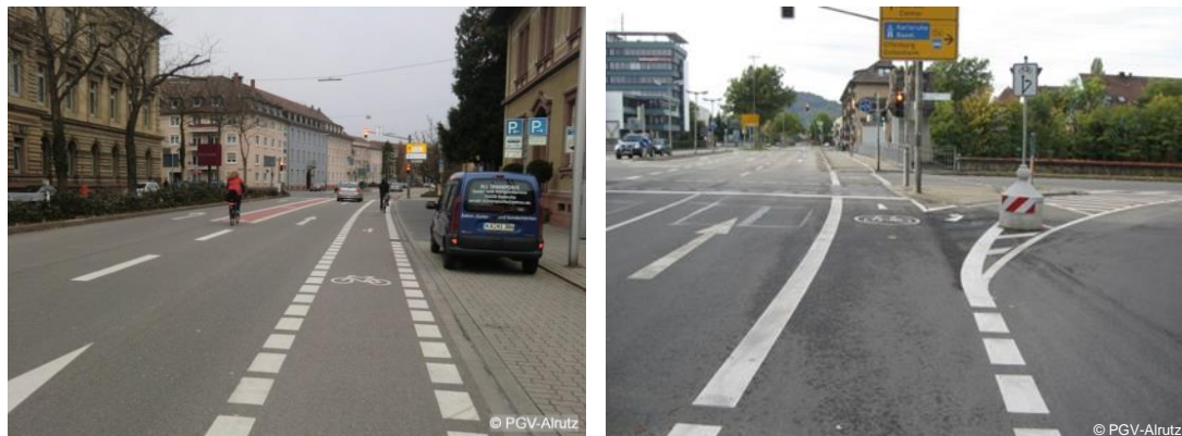
Abb. 6-13: Links: Direktes Links Abbiegen durch Radfahrstreifen (Beispiel Karlsruhe) Rechts: Indirektes Links Abbiegen mit Aufstellbereich (Beispiel Freiburg)
