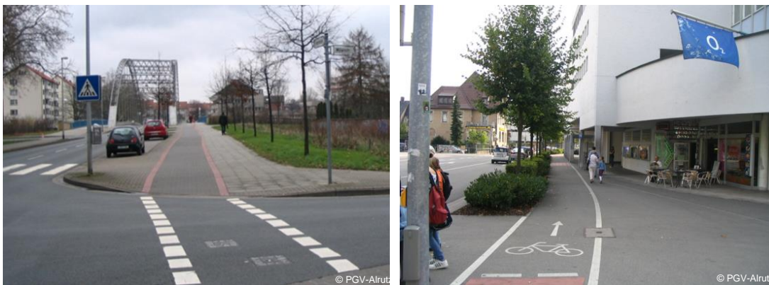
Abb. 6-3: Radwege ohne Benutzungspflicht: Baulich eindeutig (links) und Kennzeichnung durch Trennlinie und Fahrradpiktogramm (rechts)
