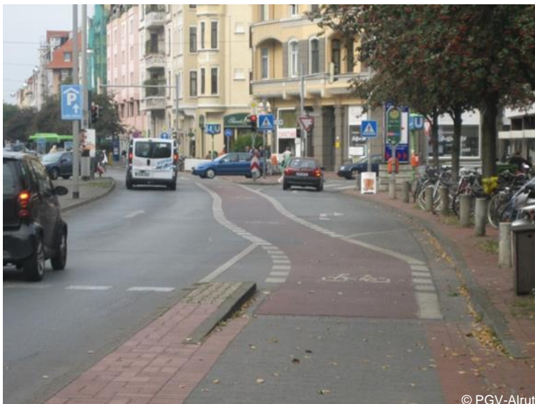
Abb. 6-10: Übergang Radweg in Radfahrstreifen an signalisiertem Knotenpunkt (Beispiel Hannover)
