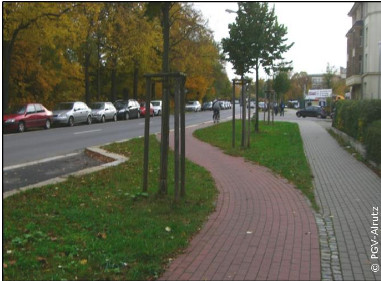
Abb. 6-9: Radverkehr wird im Vorfeld des Knotens an den Fahrbahnrand und damit ins Sichtfeld des Kfz-Verkehrs geführt (Beispiel Offenburg)
