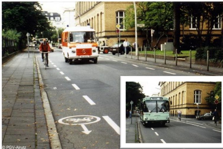
Abb. 6-6: Schutzstreifen als Schonraum für Radfahrende und als „Reservefläche“ für große Fahrzeuge (Beispiel Bonn)
