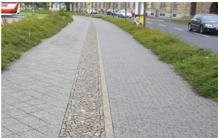
Abb. 6-2: Vom Gehweg getrennter Radweg (Beispiel Leipzig)
